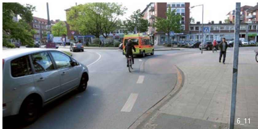
Der Velobypass schützt den Kreisel verlassende Velofahrende vor dem Kurvenschneiden der ausfahrenden Fahrzeuge.
