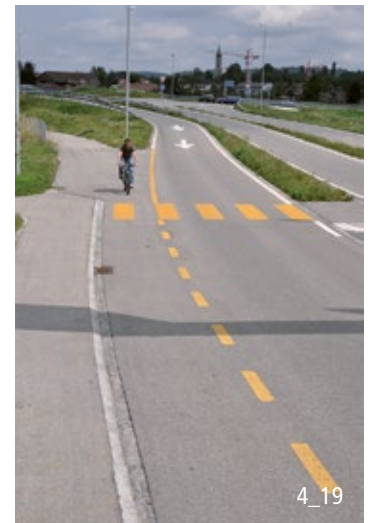
Rückführung eines Radwegs mit Trennstreifen.
