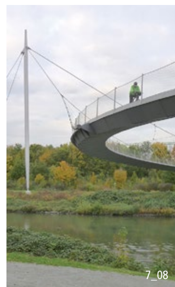
Brücken können als Merkpunkte im Orts- und Landschaftsbild gestaltet werden (Deutschland).
