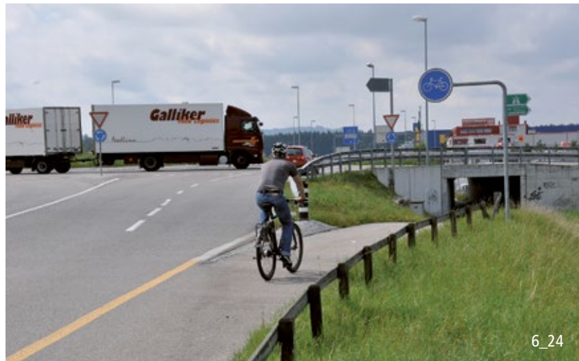
Veloumfahrung des zweistreifigen Kreisels mit niveaufreier Querung.
