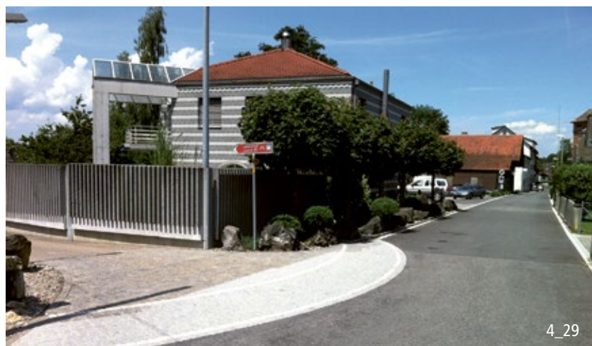
Seitliche Verengung zur Verbesserung der Sichtverhältnisse und der Erkennbarkeit der Querung.
