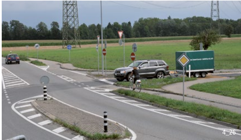
Vortrittsberechtigte Querung über eine einmündende Strasse.
