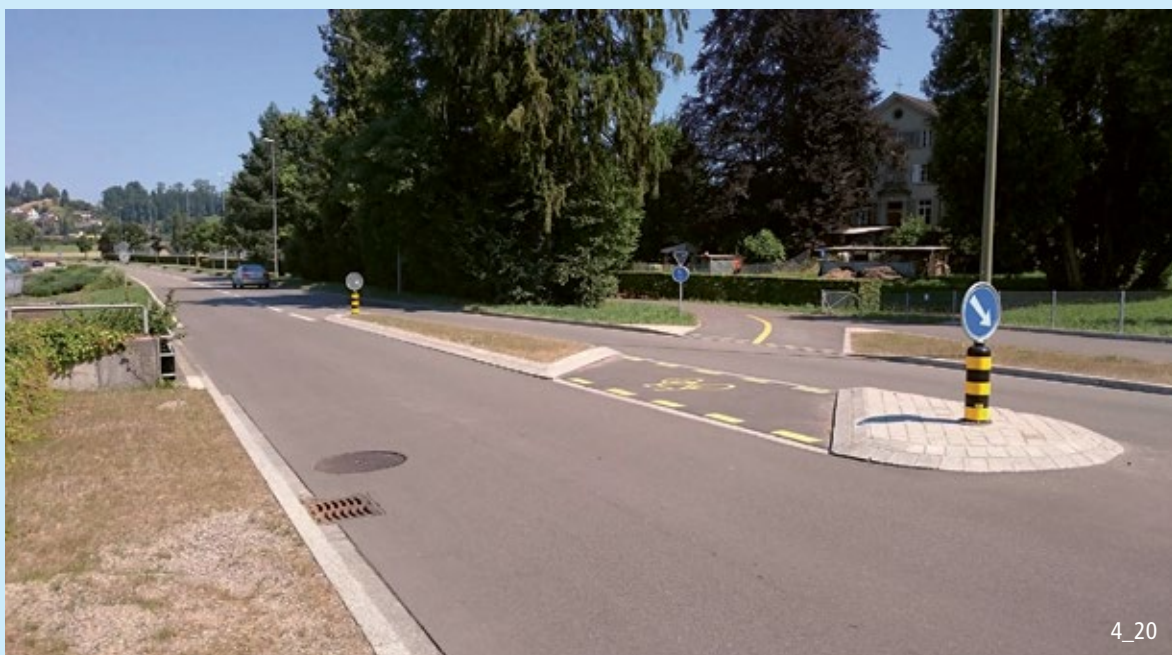
Übergang eines Zweirichtungsradwegs am Ortseingang.
