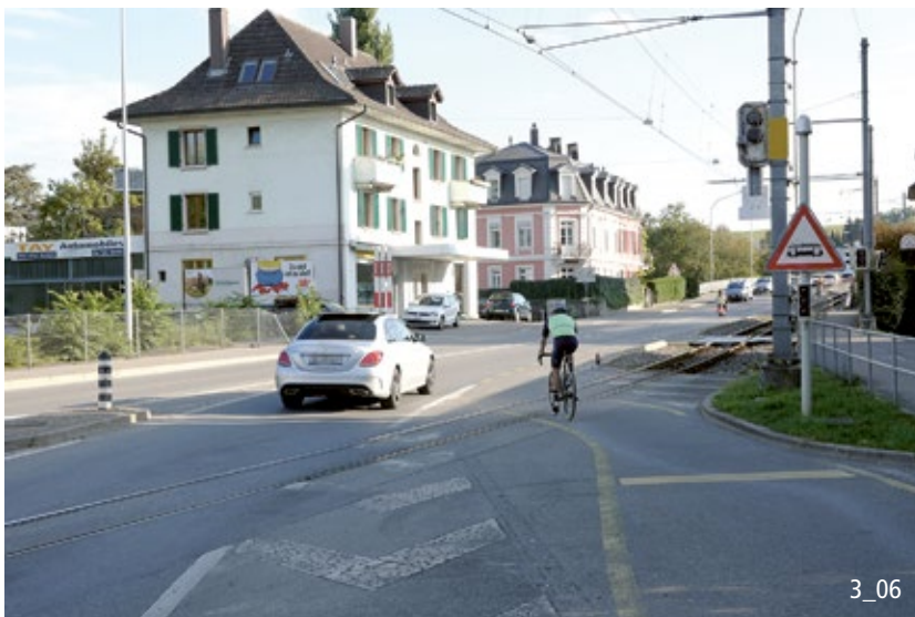
Verbesserung des Querungswinkels abseits des Motorfahrzeugverkehrs.
