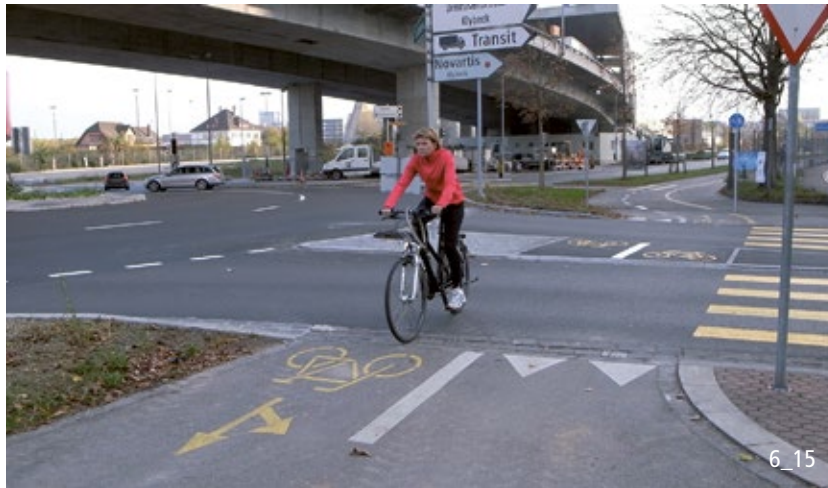
Zweirichtungsradweg mit nicht vortrittsberechtigter Querung.
