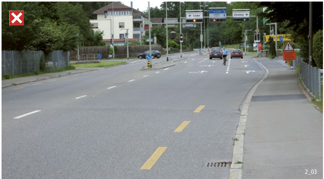
Veloinfrastruktur endet vor der Kreuzung.
