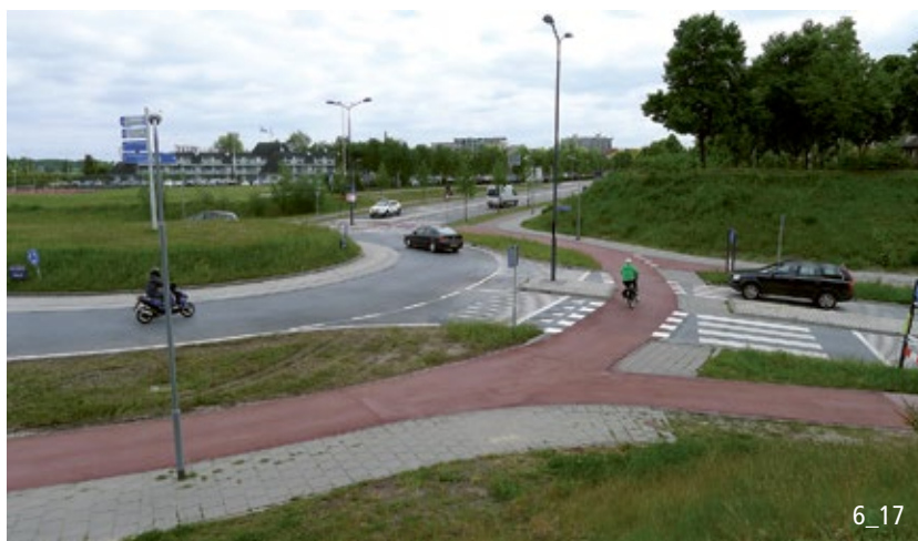
Abgesetzter Einrichtungradweg mit vortrittsberechtigter Führung (Niederlande).
