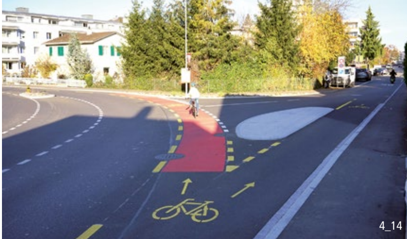
Die Veloweiche verdeutlicht die Fahrrichtungen und ermöglicht eine komfortable und sichere Geradeausfahrt.
