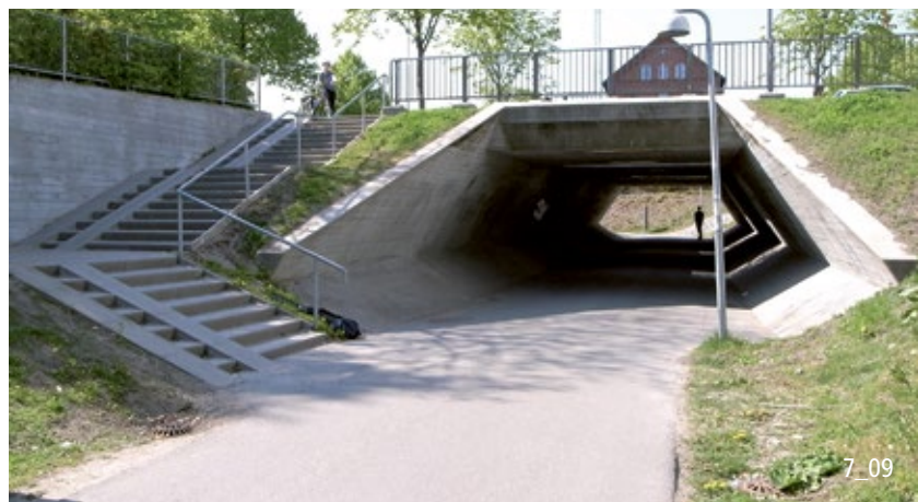
Rautenförmige Unterführungen wirken grosszügig und die lichte Breite lässt sich optimal ausnützen (Dänemark).
