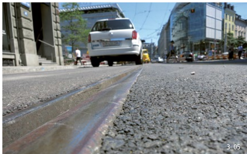
Der Gleisüberstand sollte beim Einbau nicht mehr als 3 mm betragen.
